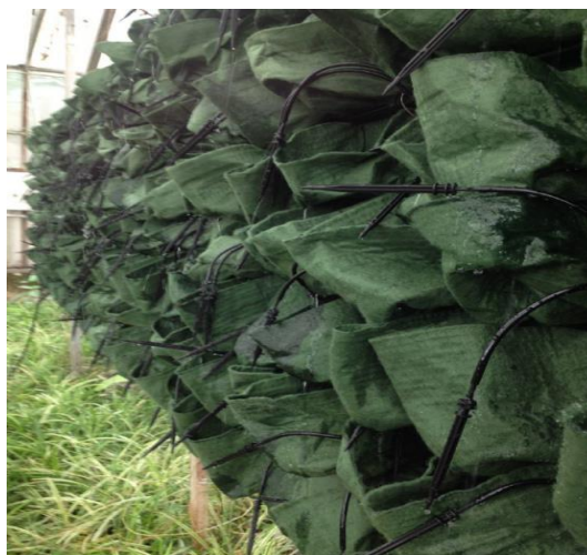
图 4 安装好的植物滴管系统
